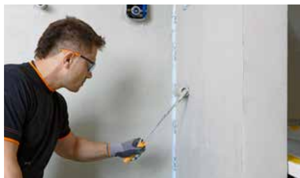
Après 1 à 2 heures de séchage (produit sec au toucher), appliquer une seconde couche de PCI Lastogum. Votre support est prêt à carrelé !
