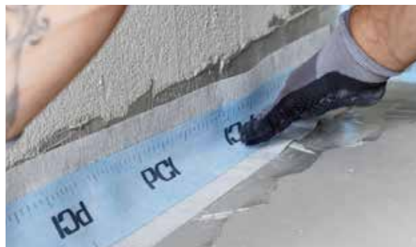
Positionner les bandes et angles d'étanchéité en les marouflant dans PCI Lastogum.
