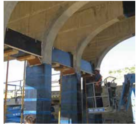
Renfort par confinement
